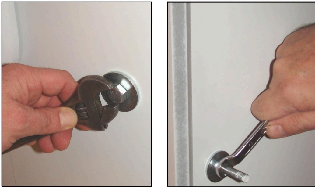
Figura 3-5. Detalle del ajuste de la varilla roscada. (Izquierda: extremo frontal – Derecha: extremo trasero).
