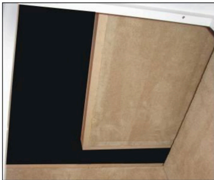
Figura 3-6. Detalle de la colocación del Panel Superior Techo.
